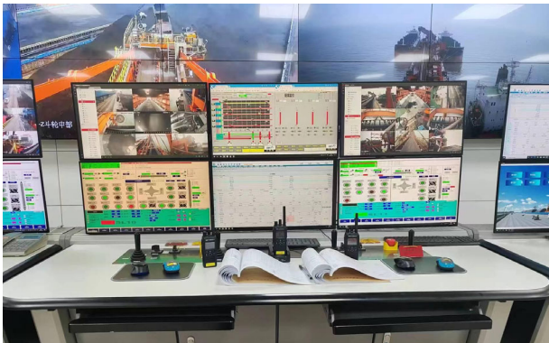
图 3 装船自动化远程监控工位
