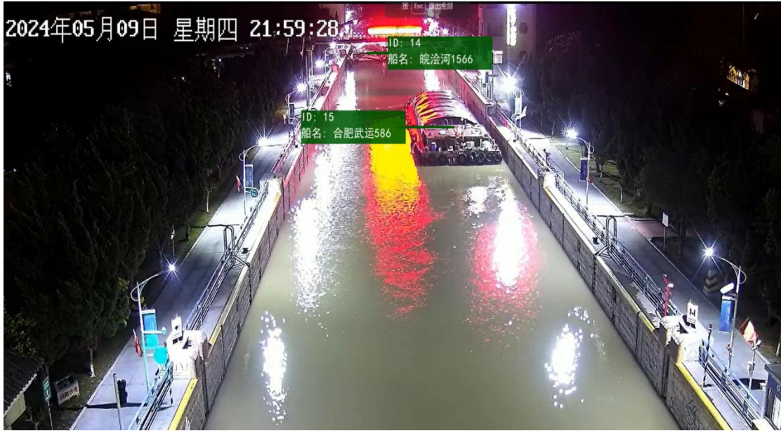
图20. 闸室全景AR
